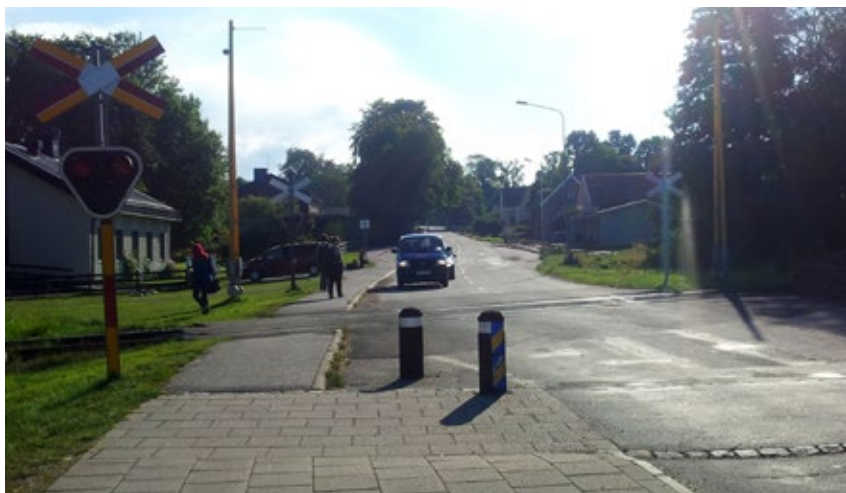
Järnvägsövergång vid stationen i Hällekis.
